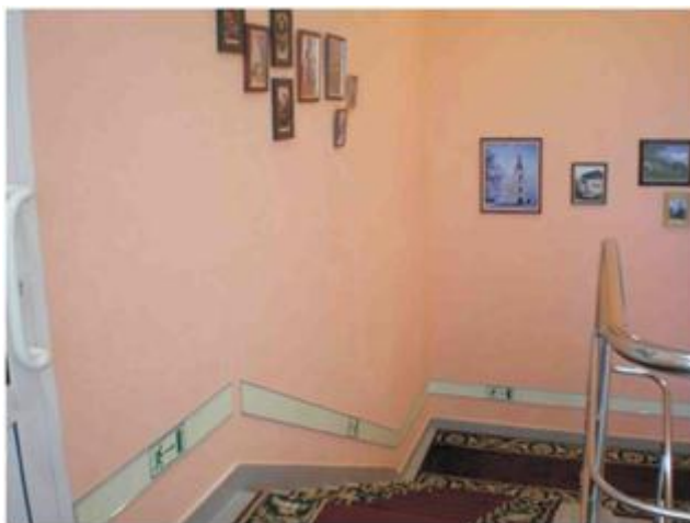
Рисунок А.5 - Вариант ФЭС с использованием направляющей линии шириной 100 мм и эвакуационных знаков направления движения
